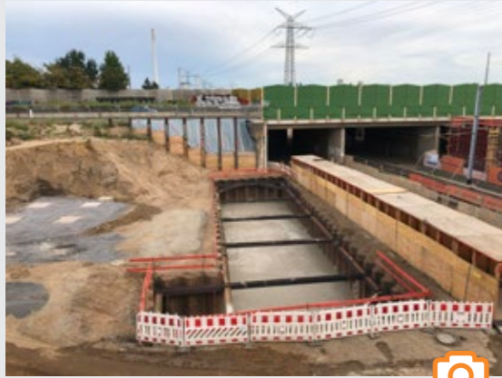
Fundament des Widerlagers beim Bauwerk „KVB/Spoerkelhof“
